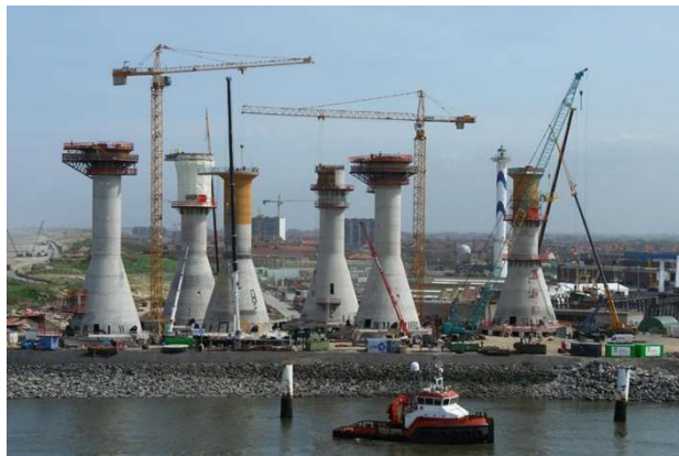
Figura 2 Strutture a gravità
