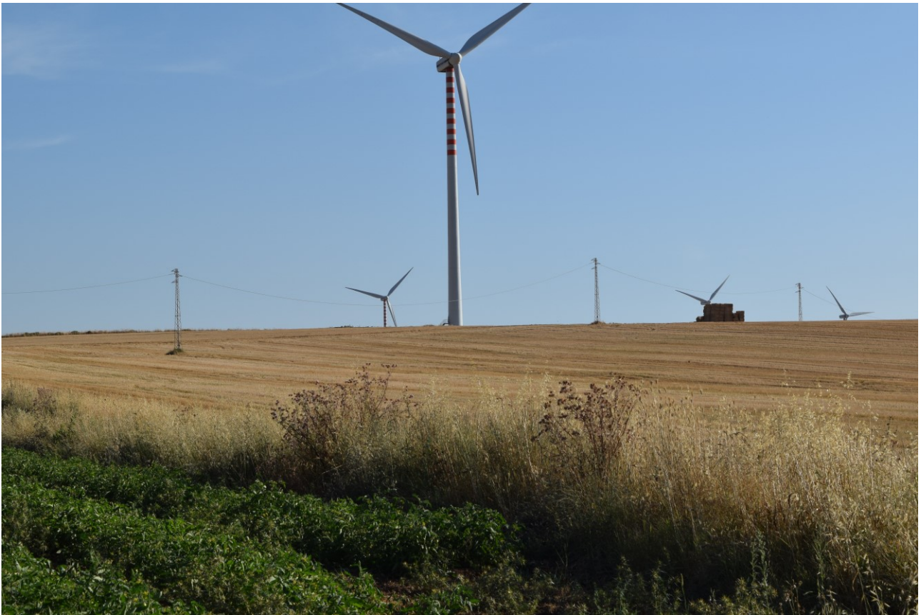
Figura 13: Foto inserimento P11 Vista fotografica P12; l'impianto è situato alle spalle della prima torre eolica
