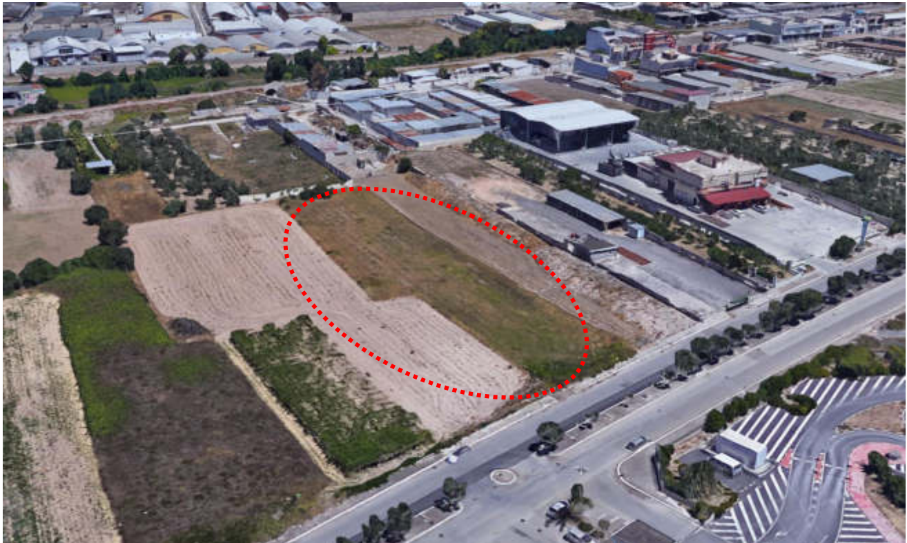
Figura 56 Contesto territoriale in cui si sviluppa l'area di intervento. Fonte: google earth 3d
