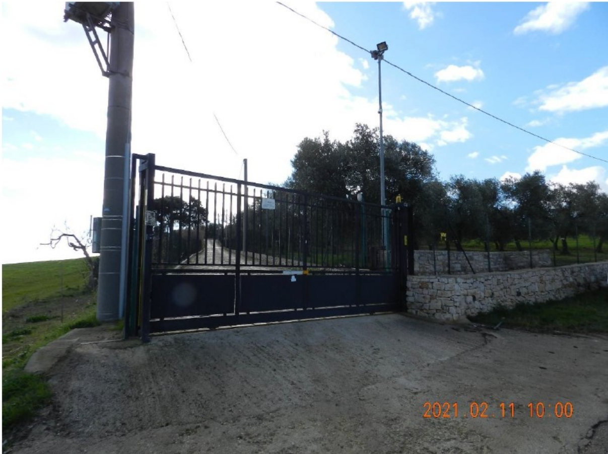
Figura 2: Punto di Vista n° 1, lato Nord-Ovest
