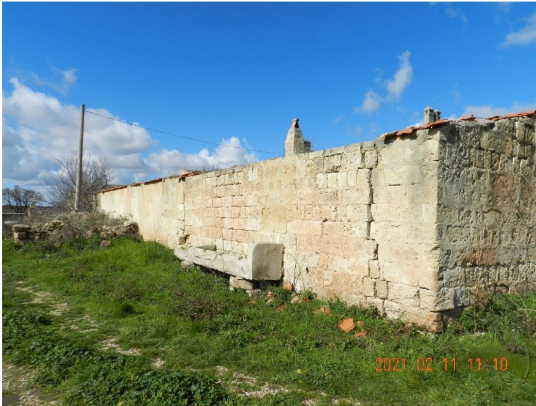
Figura 28: Punto di Vista n° 3, lato Sud
