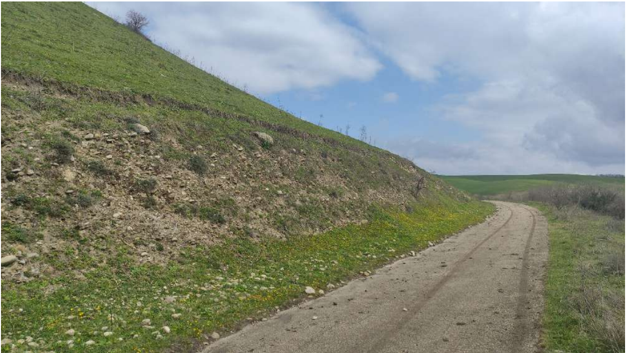
Foto 6a – Punto di Presa n° 6 Stato di Fatto
