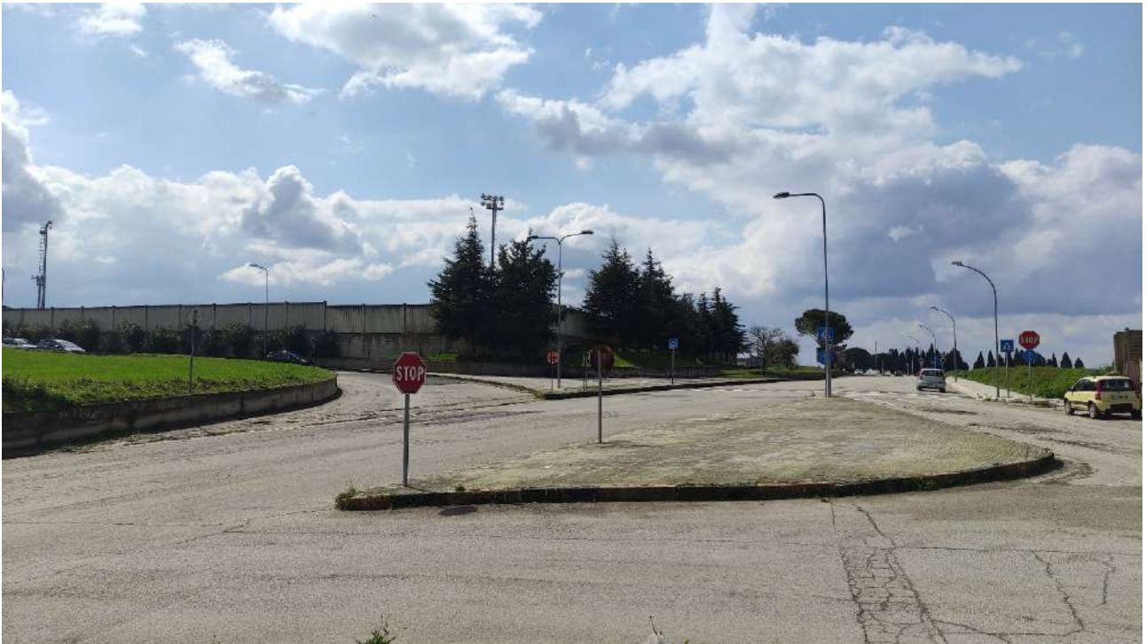
Foto 13a – Punto di Presa n° 13 Stato di Fatto
