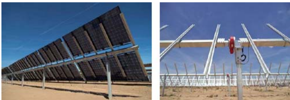
Figura 5 - Vista prospettica e struttura dell'inseguitore solare monoassiale
