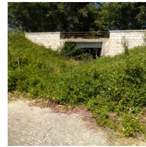
Figura 15 - Presenza di un attraversamento idraulico in corrispondenza della SP 22, poco più a Est dell'area di intervento
