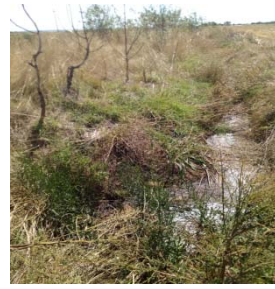
Figura 14 - Fossi di scolo completamente ricoperti da vegetazione infestante
