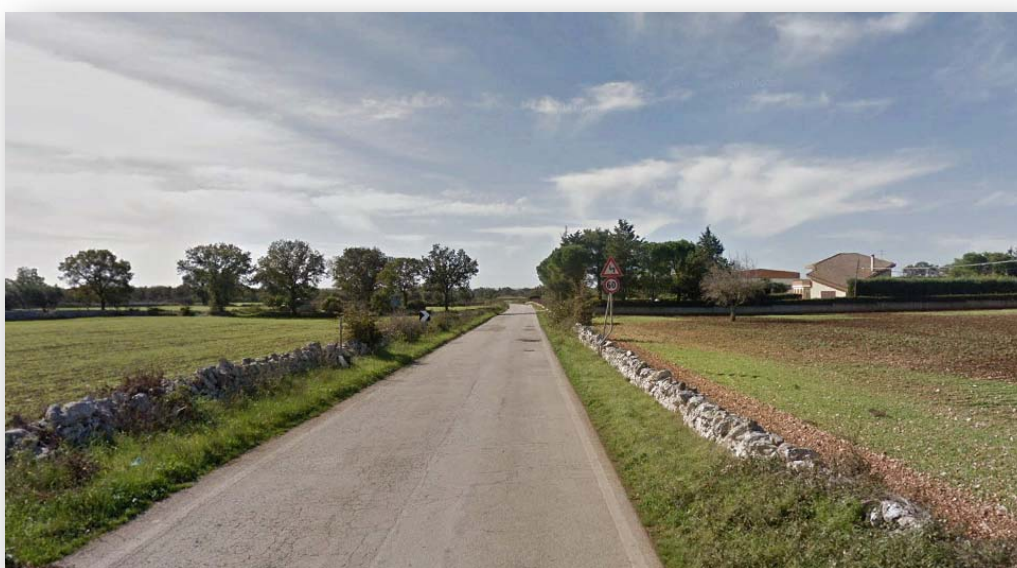
Figura 10 – Esempio strada di accesso al parco
