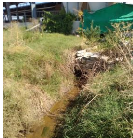
Figura 3-3 - Acque di scarico provenienti dalla Masseria, che dovranno essere considerate come contributo aggiuntivo nelle verifiche dei fossi
