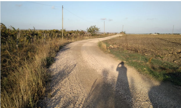
Foto 47 p.lla 46 e Cavidotto su strada sterrata
