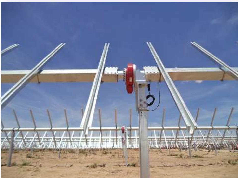
**Figura 2 – Struttura dell'inseguitore solare monoassiale**
