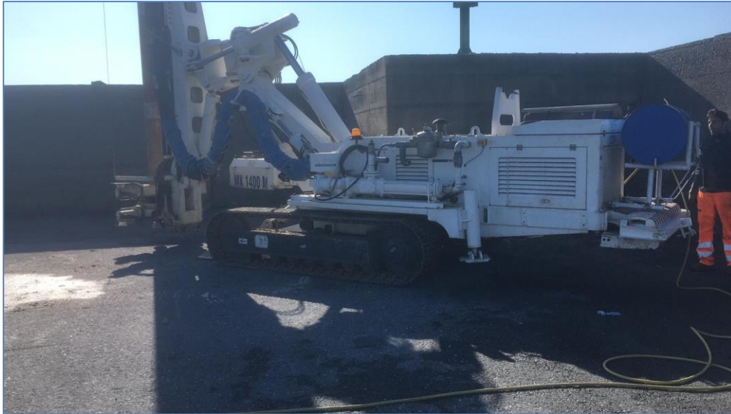
Foto 1 – Esecuzione del sondaggio a rotazione con carotaggio continuo denominato S1.
