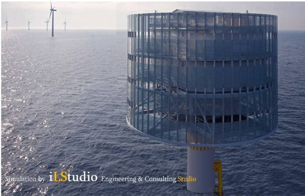
Figura 4.3 – Sottostazione di trasformazione offshore. Elaborazione iLStudio.
