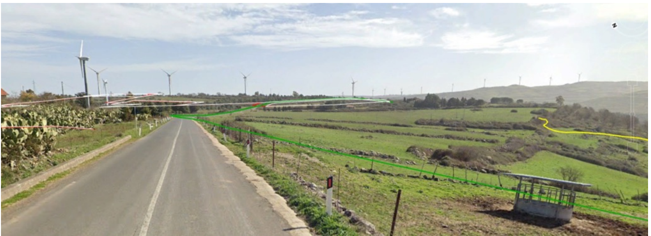
Da SS124 al centro di area C
