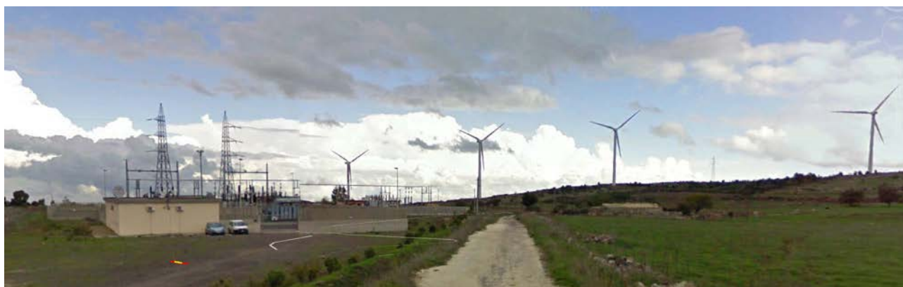
Area B da SS124 Sostegni elettrodotti Aerei AT e Pale eoliche
