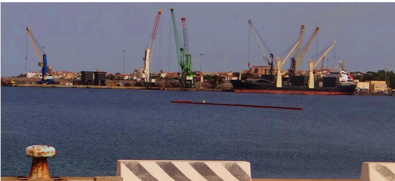
Figura 6-71: Nave Ormeggiata lungo la Banchina Est di Portovesme
