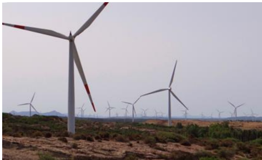
Figura 6-69: Vista sul Parco Eolico sopra la SP2
