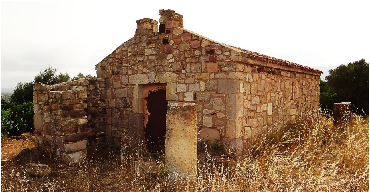
Figura 2-10: Chiesa di Santa Maria di Flumentepido
