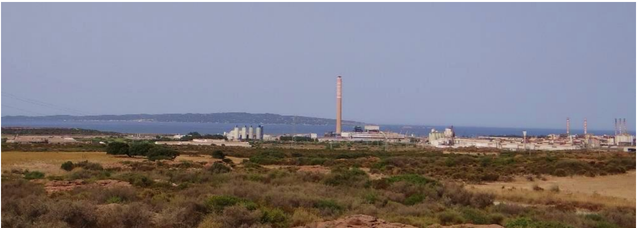
Figura 2-16: Vista dal Parco Eolico sopra la SP2 (ad Est dell'Area di Intervento)
