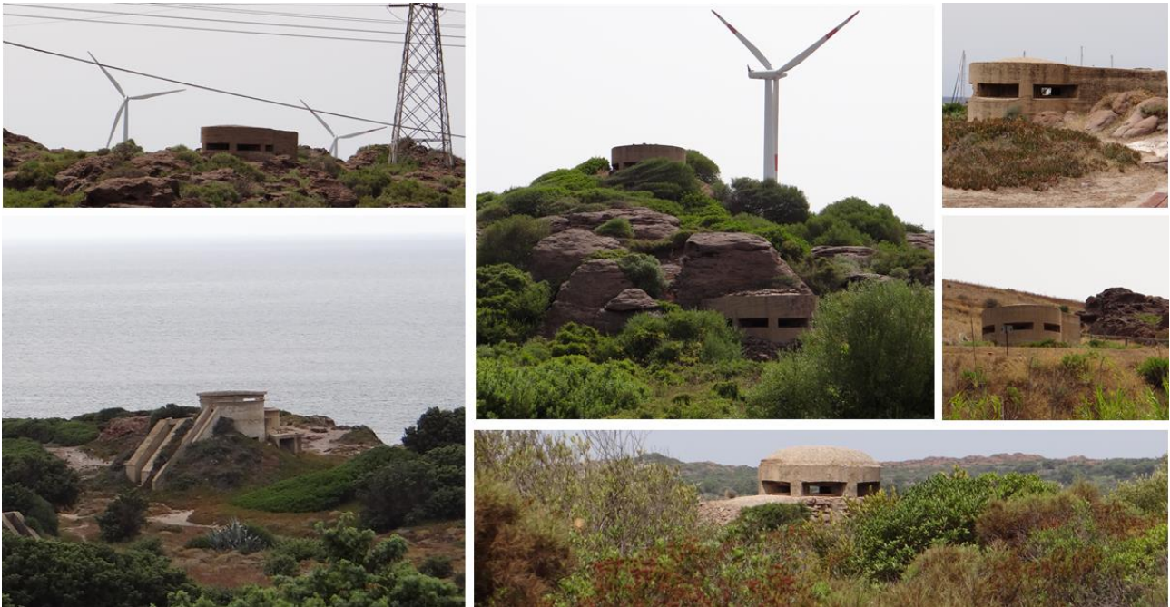
Figura 2-8: Casematte tra Capo Altano e Portovesme
