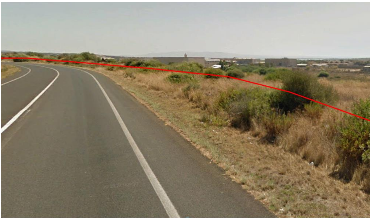
Figura 3-8 Vista in direzione sud del versante meridionale della S.P. n.2 (Località Concali Arrubbiu, km 3,00)
