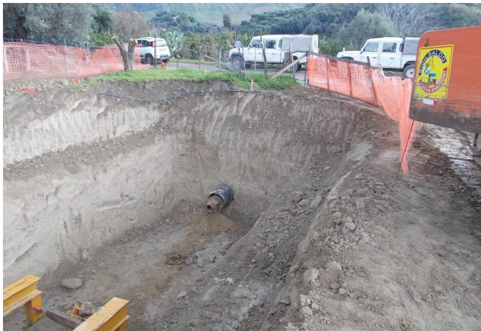
Figura 6-10: Esempio di opere di trivellazione con spingitubo
