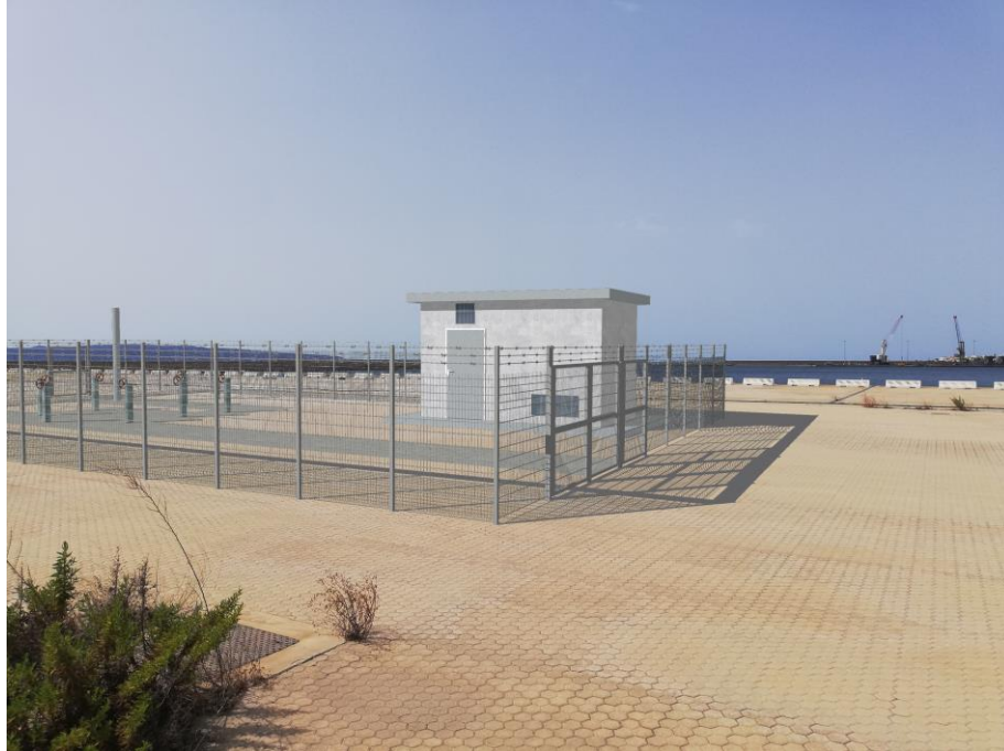
Figura 3-32 Punto di vista n.1 – foto simulazione 1 (senza mitigazione) modificata in seguito a richiesta di integrazione MITE
