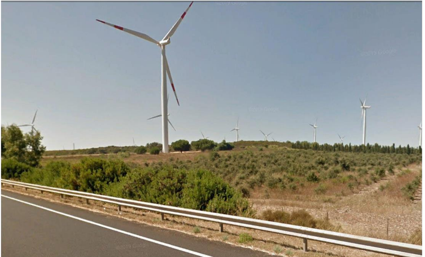
Figura 3-15 Vista, dall'area dove sarà collocato il PIDI n.9, in direzione nord verso il paesaggio dell'entroterra, sul versante settentrionale della S.P.n2
