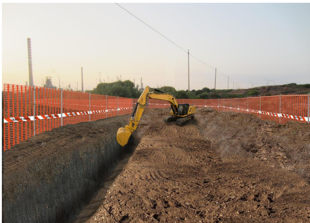
Figura 3-50 Punto di vista n.5: fotosimulazione 2. Cantiere in fase di scavo
