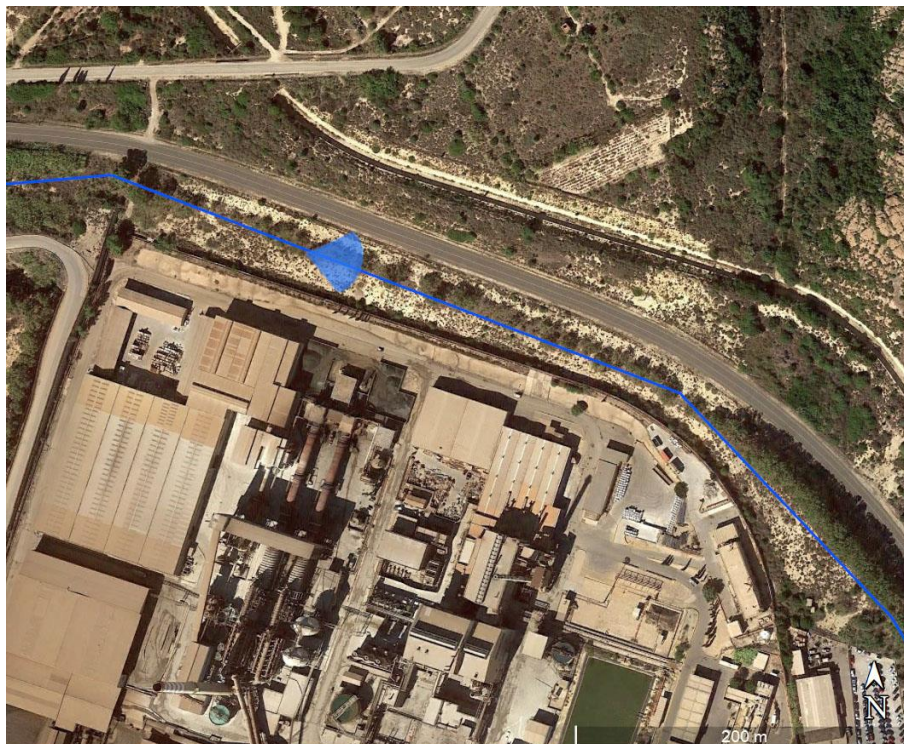
Figura 3-53 Punto di vista n°6 (attraversamenti dell'Asse interno industriale Portovesme e del Rio de Su Cannoni).
