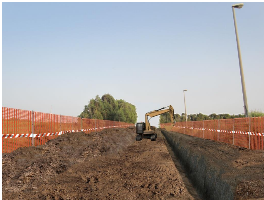
Figura 3-40 Punto di vista n.3: fotosimulazione 2. Vista del cantiere in fase di scavo.
