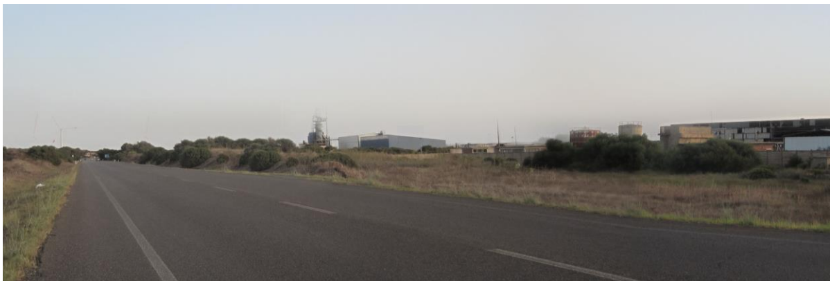
Figura 3-34 Punto di vista n.2: situazione ante operam
