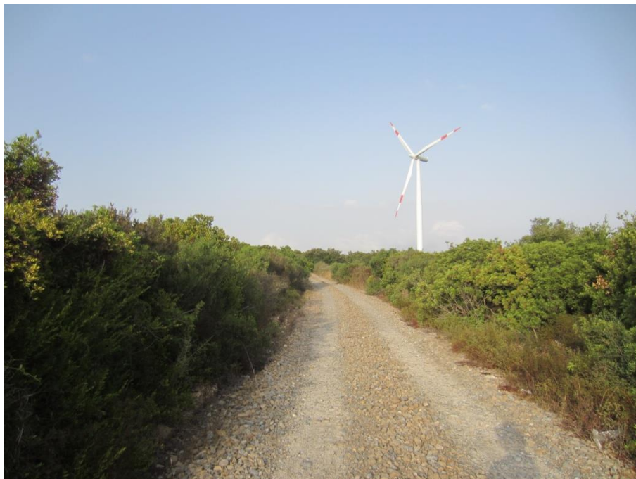
Figura 3-44 Punto di vista n.4: situazione ante operam.
