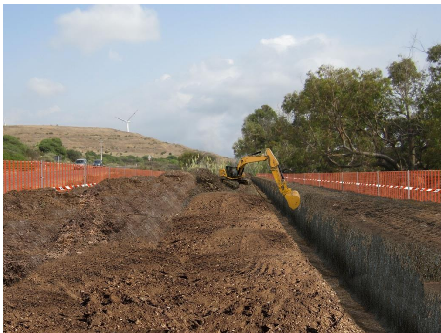
Figura 3-56 Punto di vista n°6, fotosimulazione 2: opere di scavo
