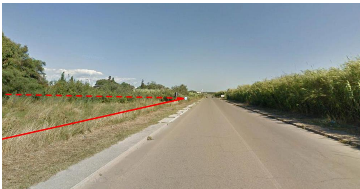
Figura 3-3 Vista dalla S.P 75bis in direzione sud-est. Il gasdotto devia a sinistra, in direzione nord, lungo la strada locale che unisce le S.P. 75 bis e la S.P. n.2
