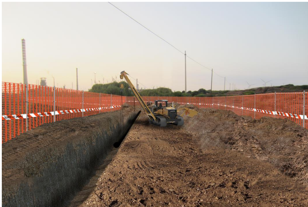
Figura 3-51 Punto di vista n°5: fotosimulazione n°3. Cantiere in fase di posa delle tubazioni
