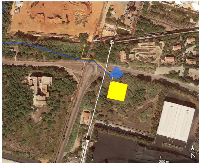
Figura 3-59 Punto di vista 7: impianto HPRS
