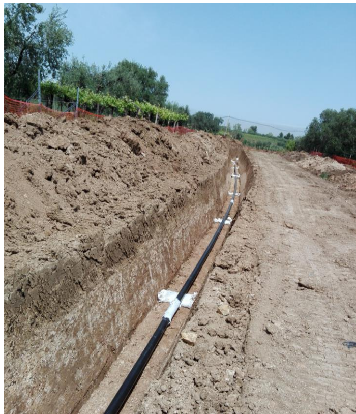
Figura 6-7: Esempio di posa della condotta
