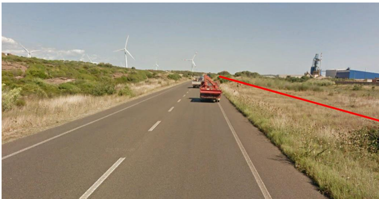
Figura 3-7 Vista in direzione sud-ovest dalla S.P. n.2
