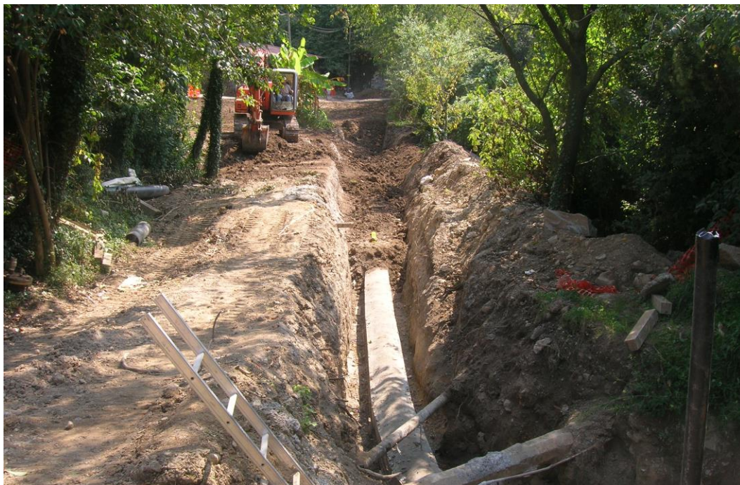
Figura 6-8: Esempio di rinterro della condotta (1)
