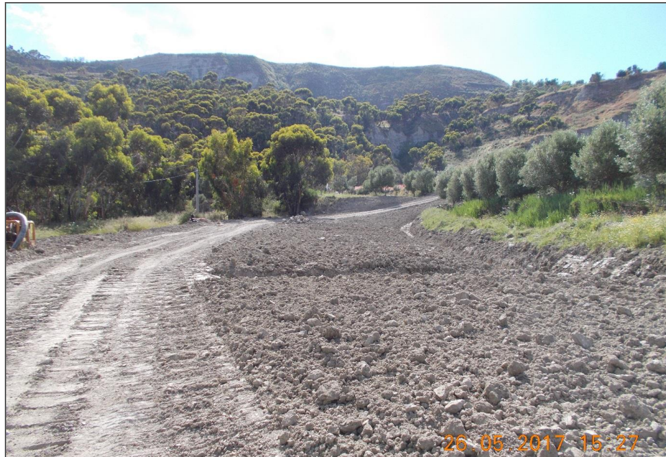
Figura 6-9: Esempio di rinterro della condotta (2)
