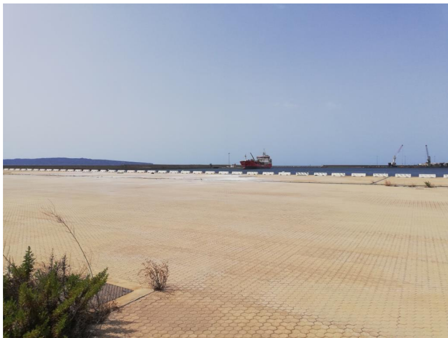
Figura 3-31 Punto di vista: 1 situazione ante operam
