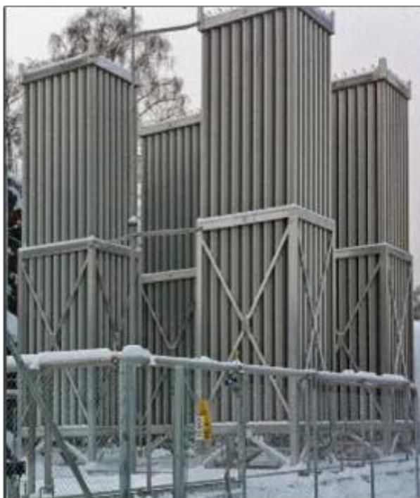
**Figura 25** - Vaporizzatori AAV
