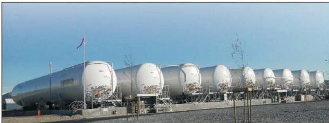
**Figura 18** - Esempio di serbatoi criogenici (impianto GNL a Fredrikstad – Norvegia)
