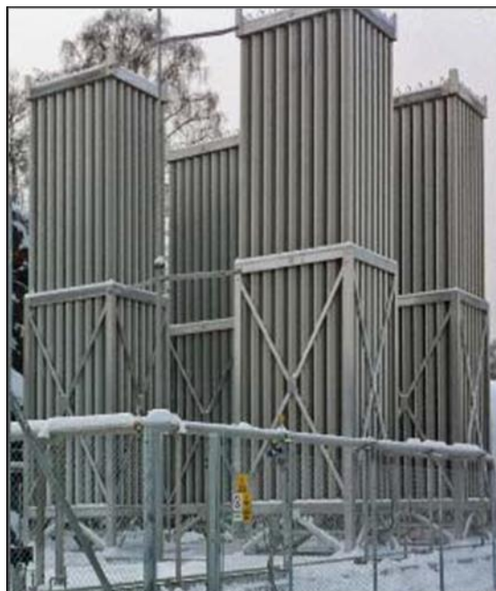
Figura 30 - Vaporizzatori AAV
