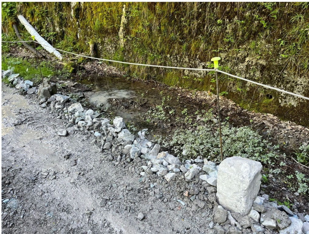
Figura 10- Dettagli intervento di protezione raccolta acqua
