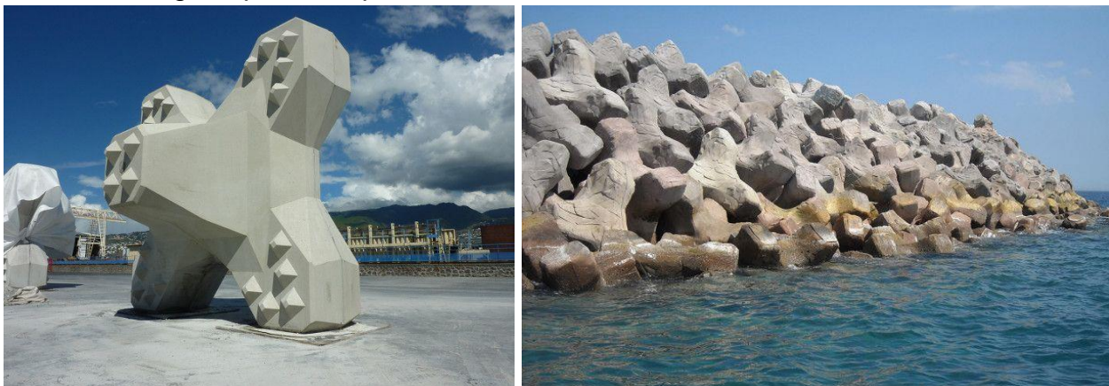
Figura 2-6: Mantellata single-layer in massi artificiali tipo Ecopode™ (dx, parti emerse) e tipo Accropode™ (sx, parti sommerse)
