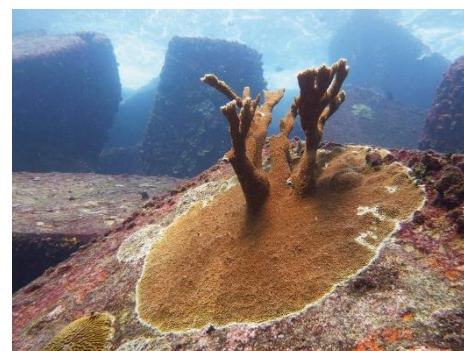
Figura 3-6: Popolamenti bentonici su elementi prefabbricati di mantellate
