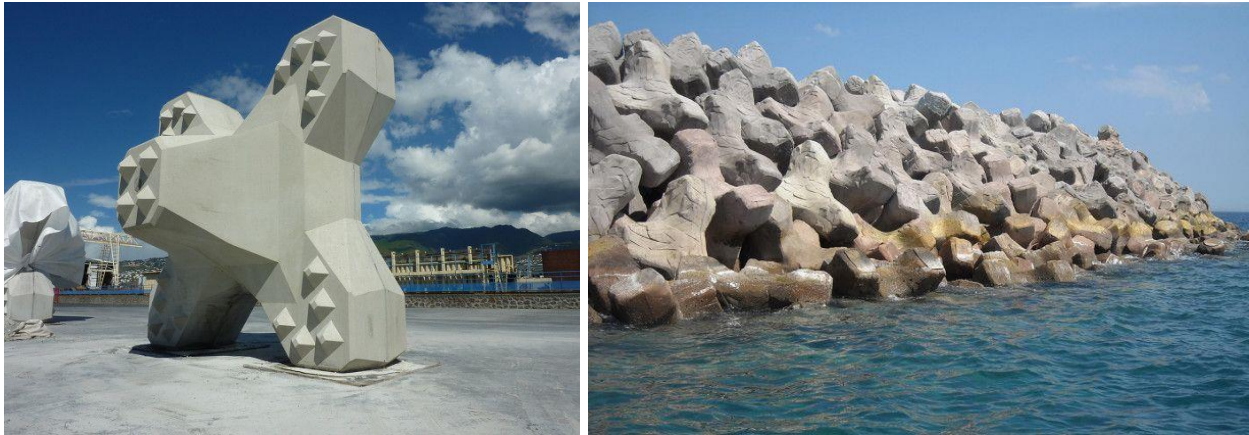
Figura 2-1: Mantellata single-layer in massi artificiali tipo Ecopode™ (dx, parti emerse) e tipo Accropode™ (sx, parti sommerse)
