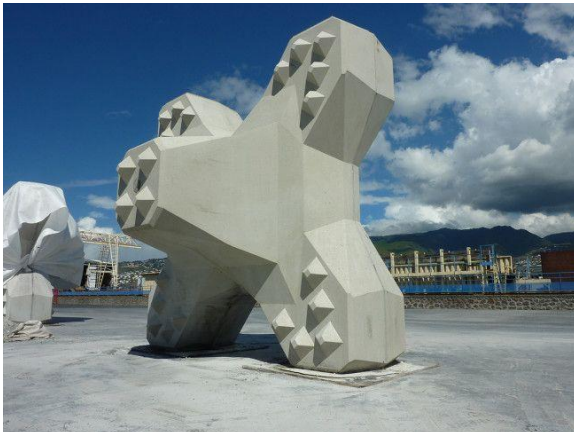
Figura 3-1: Mantellata single-layer in massi artificiali tipo Ecopode™ (dx, parti emerse) e tipo Accropode™ (sx, parti sommerse)
