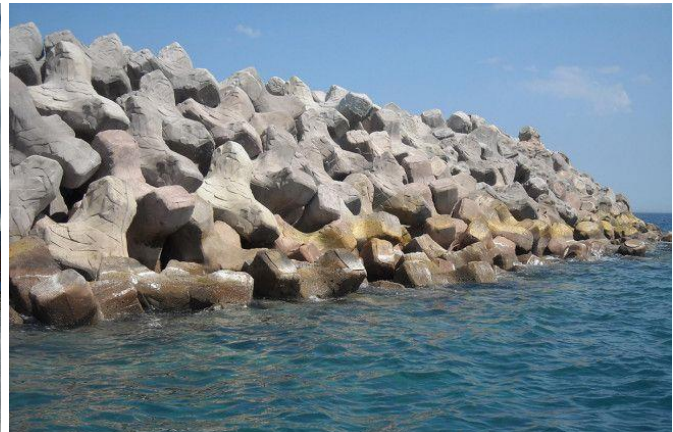
Figura 3-1: Mantellata single-layer in massi artificiali tipo Ecopode™ (dx, parti emerse) e tipo Accropode™ (sx, parti sommerse)
