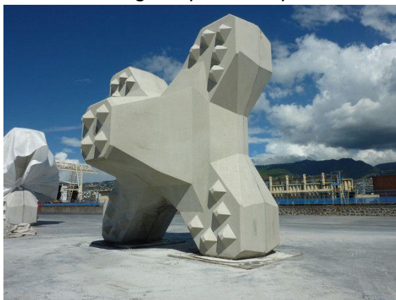
Figura 2-16: Mantellata single-layer in massi artificiali tipo Ecopode™ (dx, parti emerse) e tipo Accropode™ (sx, parti sommerse)
