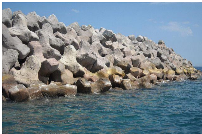
Figura 2-16: Mantellata single-layer in massi artificiali tipo Ecopode™ (dx, parti emerse) e tipo Accropode™ (sx, parti sommerse)
