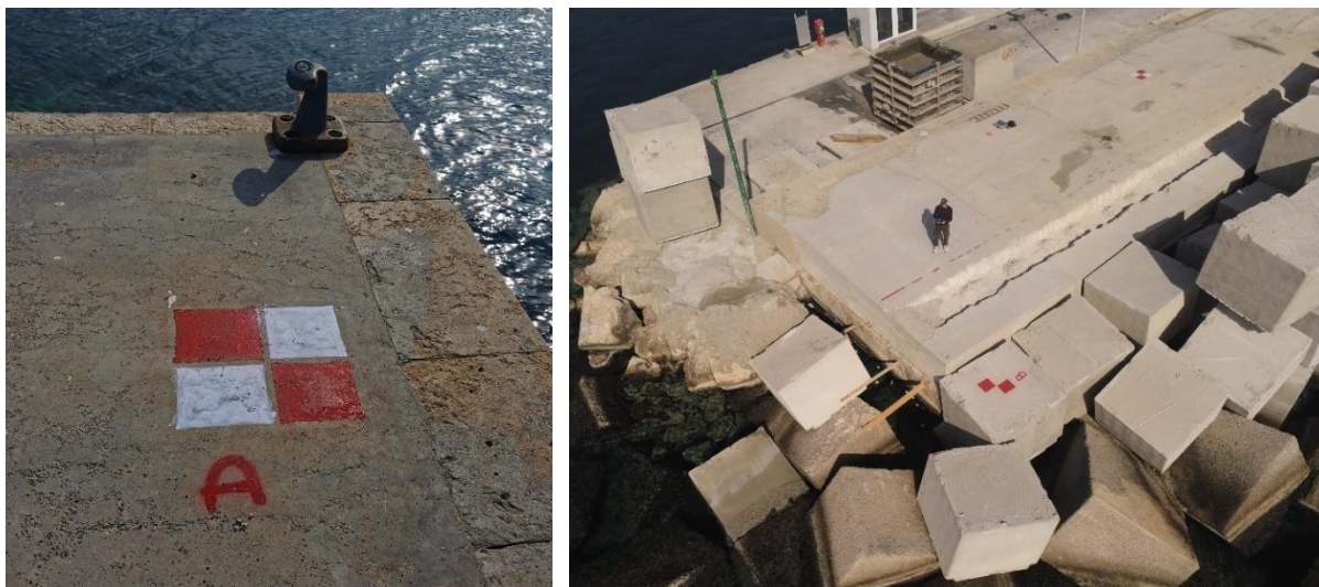
Figura 17. Ground Control Point (GCP). Punti di appoggio fotogrammetrici per la successiva georeferenziazione dei fotogrammi
