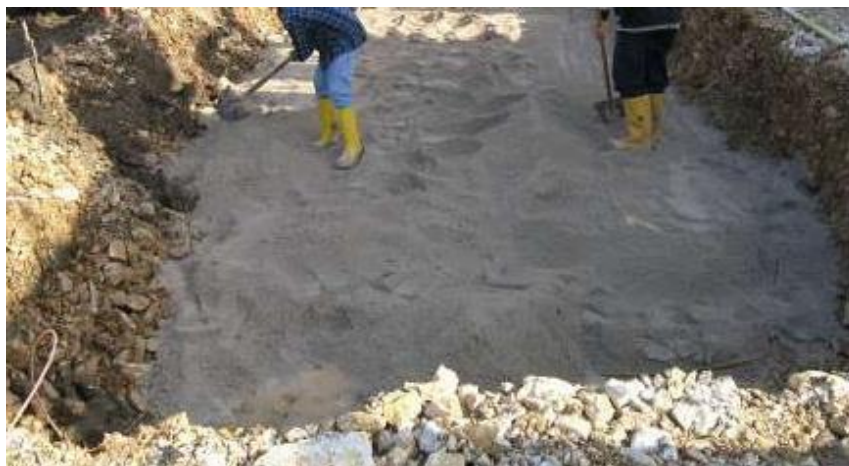
FIGURA 6 - SBANCAMENTO PIANO POSA CABINE
