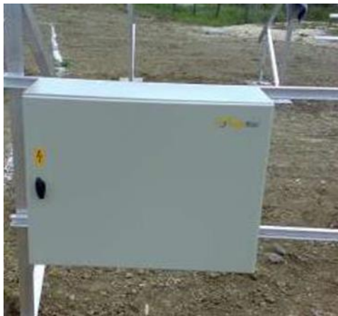
FIGURA 10 - QUADRI IN PARALLELO
