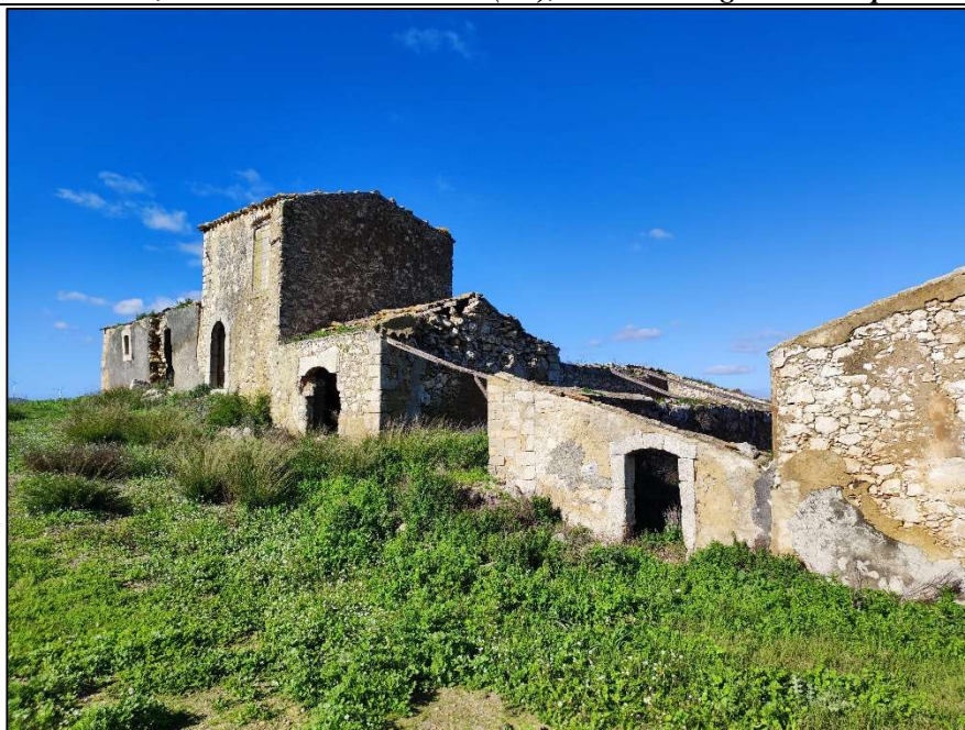
Il complesso architettonico di Case Ceppone
