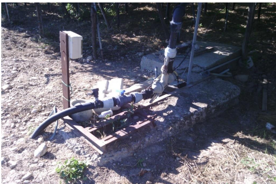
Figura 15: Vasca attualmente presente in sito, rubinetto con collegamento elettrico alla pompa del sistema di irrigazione e tubazioni in materiale plastico che seguono nel terreno
