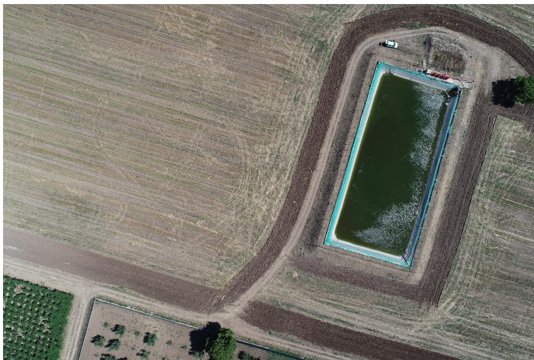
Figura 9: Vasca attualmente presente in sito, vista dall'alto, ripresa in fase di sopralluogo col drone
