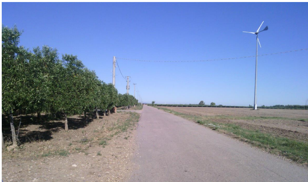
Figura 23: Pali elettrici e torre eolica esistente - vista lungo viabilità asfaltata, lato nord dell'area d'impianto, in direzione ovest
