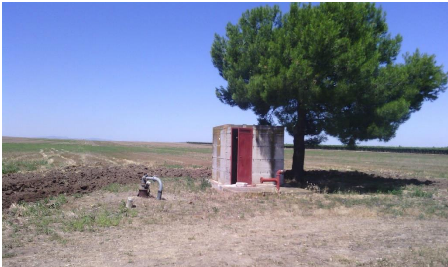
Figura 14: Vasca attualmente presente in sito, edificio a sud est della vasca
