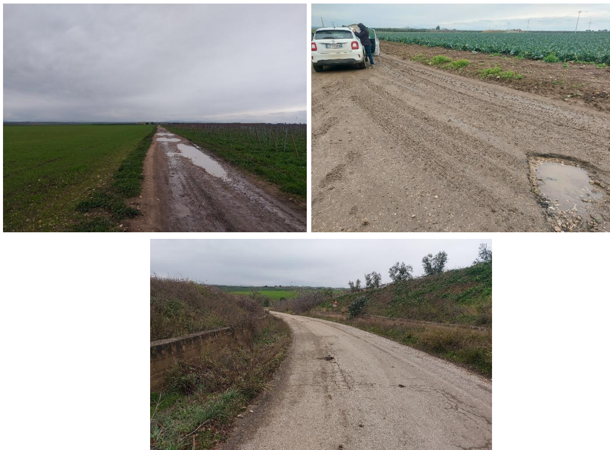
Figura 29: Foto che identifica tratto di strada sterrata, tratto di strada asfaltata e tratto di strada asfaltata con muretti di contenimento laterali
