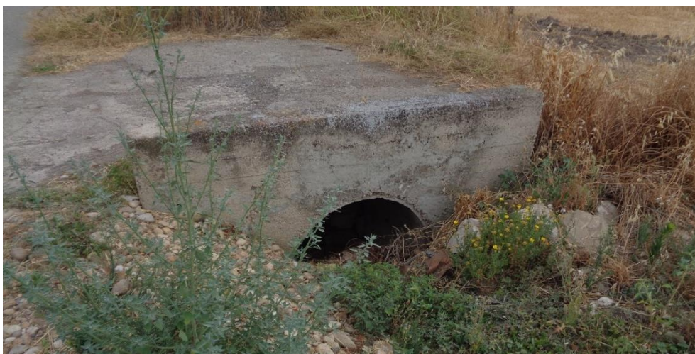
Figura 21: Attraversamenti in calcestruzzo a nord dell'area d'impianto
