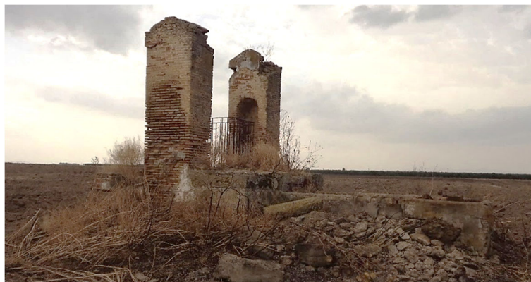
Figura 5: Pozzo artesiano ubicato nella zona ovest dell'area d'impianto
