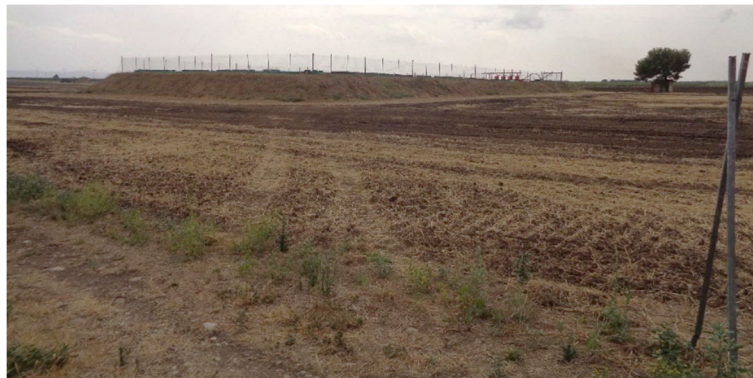
Figura 4: Vasca attualmente presente in sito, vista da nord-ovest verso sud-est
