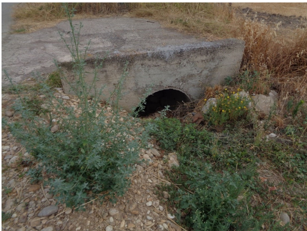
Figura 3 – Canale perimetrale sul lato Est – Nord Est
