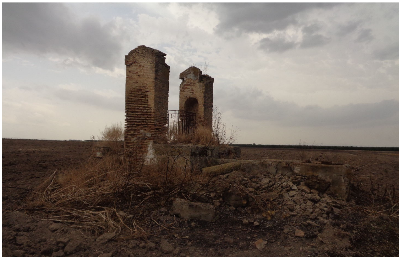
Figura 10 – Stato dei luoghi, pozzo presente in sito, da tutelare
