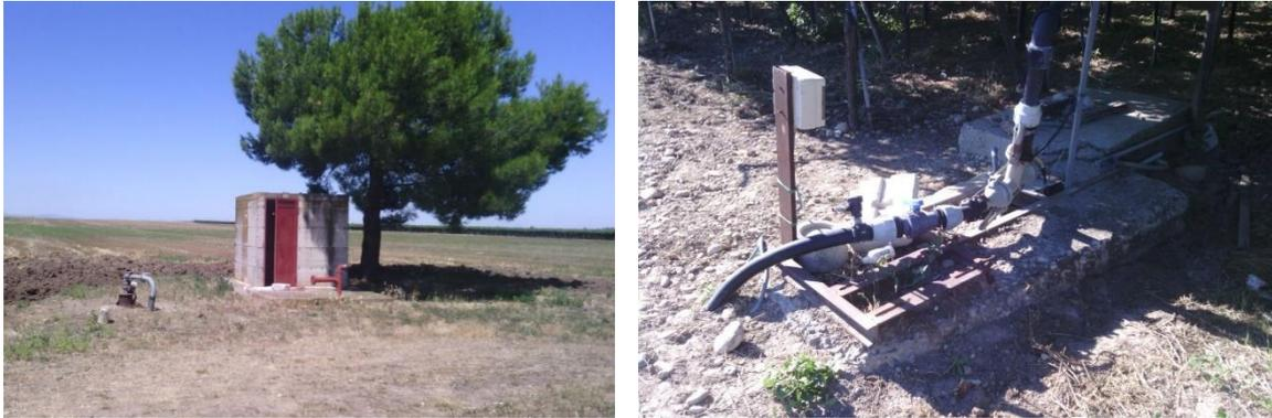
**Figura 9: Edificio a sud est della vasca attualmente presente in sito e rubinetto con collegamento elettrico alla pompa del sistema di irrigazione e tubazioni in materiale plastico che seguono nel terreno**
