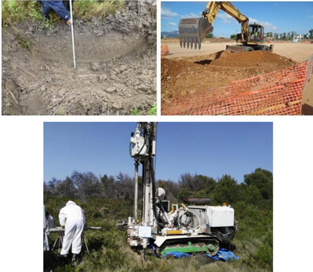
**Figura 31 – Operazioni di caratterizzazione ambientale da scavo mediante escavatore meccanico (sopra) e da sondaggio (sotto).**
