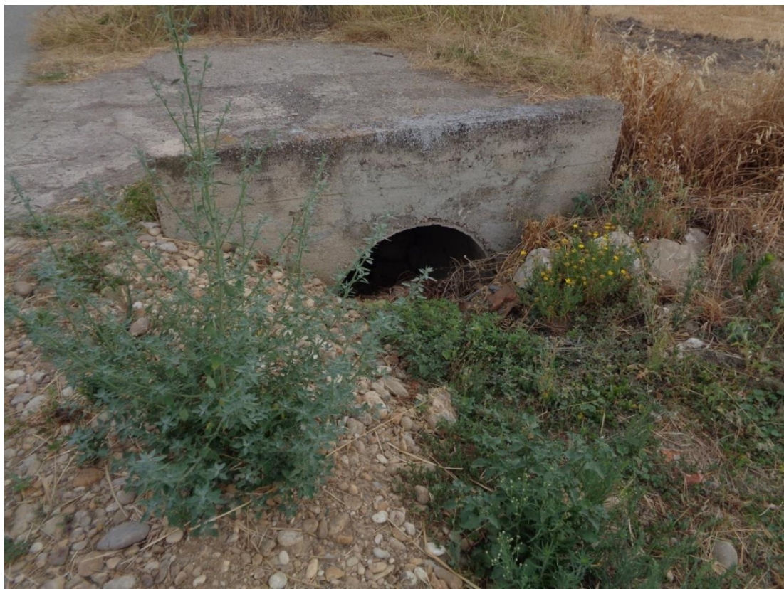
Figura 3 – Canale perimetrale sul lato Est – Nord Est
