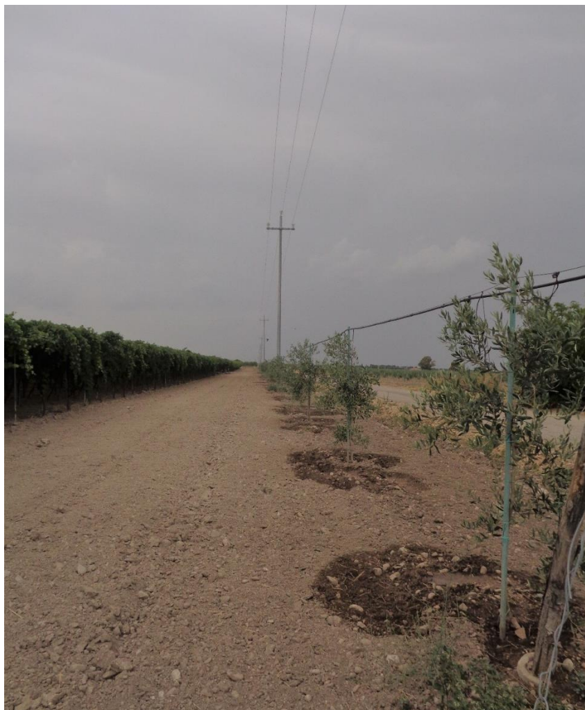
Figura 7 – Linea MT presente in sito sul lato Nord
