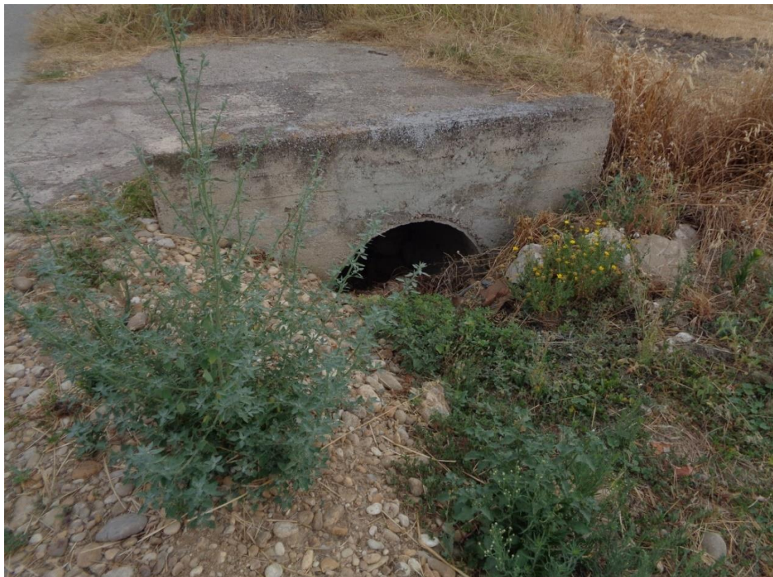
Figura 4 – Canale perimetrale sul lato Est – Nord Est
