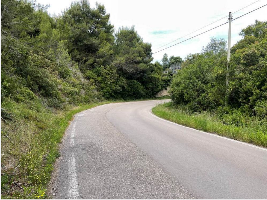
R08001003 Veduta da SO verso NE.
