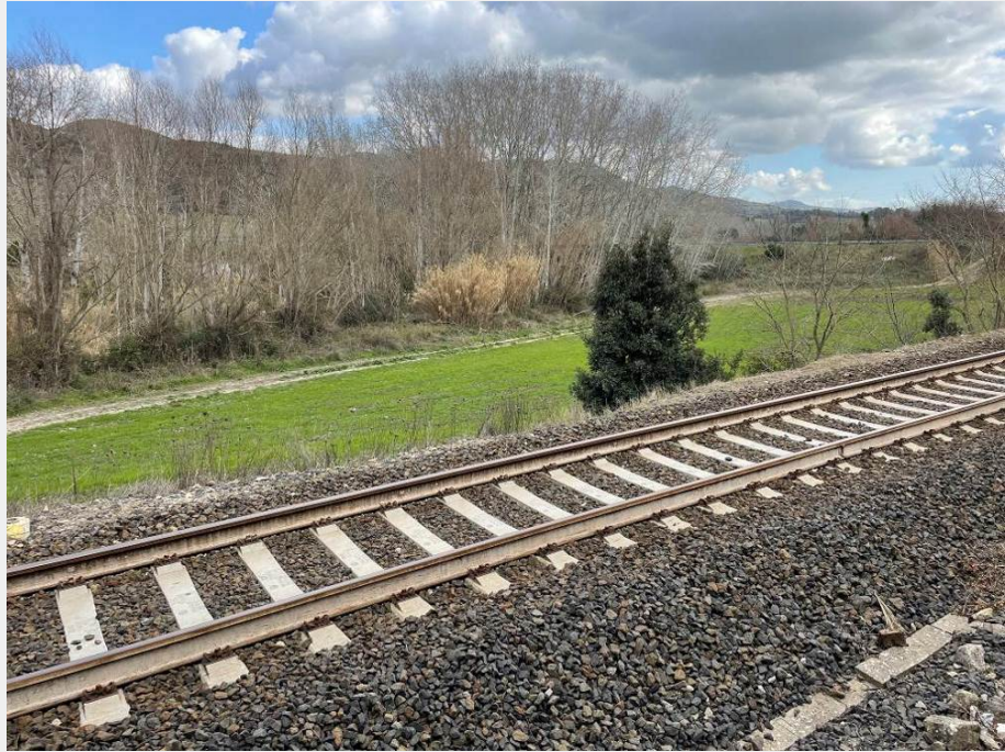
R02001016 Veduta da SO verso NE.
