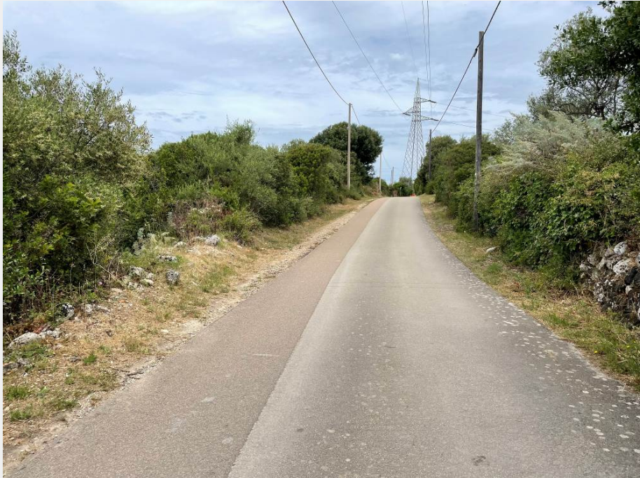
R05001004 Veduta da N verso SE.
