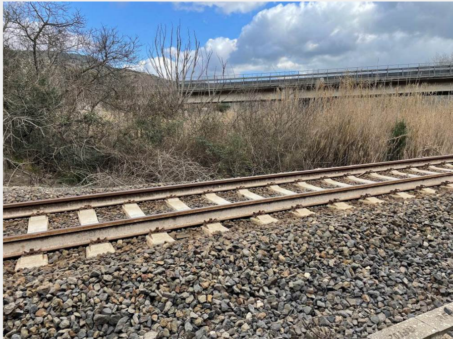
R02001014 Veduta da SO verso NE.
