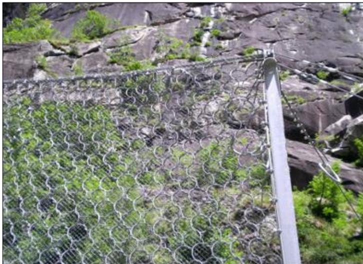
*Figura 5.7: Esempio di pannello di rete ad anelli di fune di acciaio*
