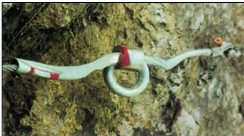
*Figura 5.8: Particolare di un ancoraggio alla parete rocciosa*
