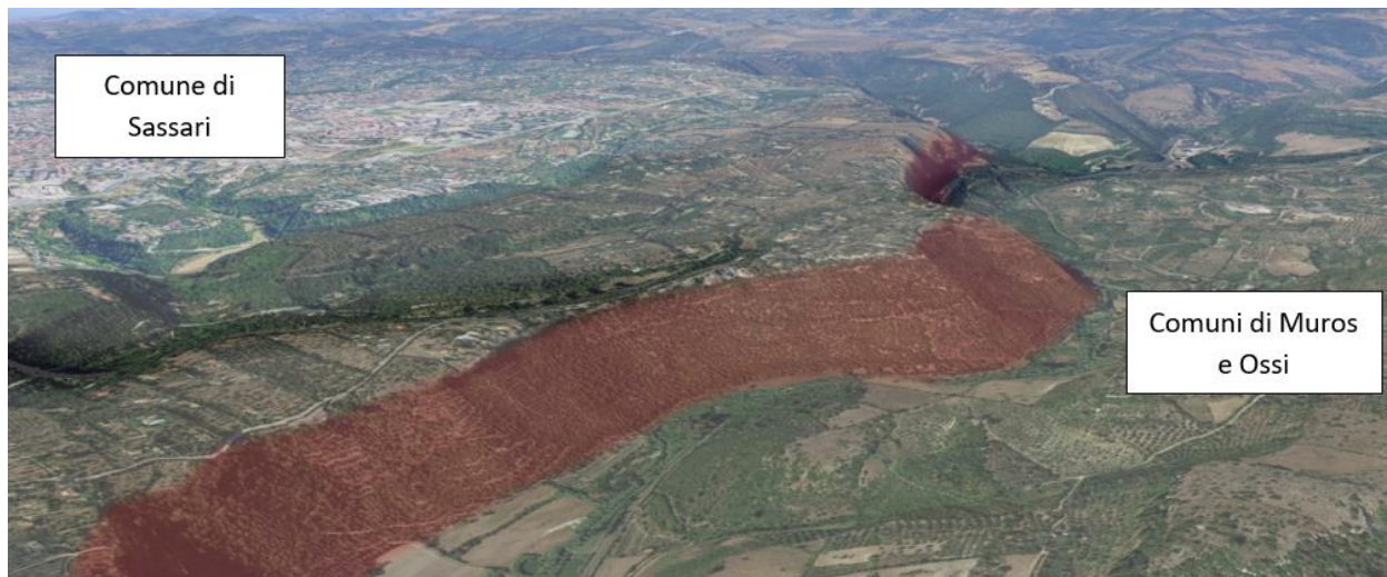
Figura 3-31 – Vista a volo d'uccello della cuesta, con individuazione in rosso del versante con forte pendenza (Fonte: Google Earth)
