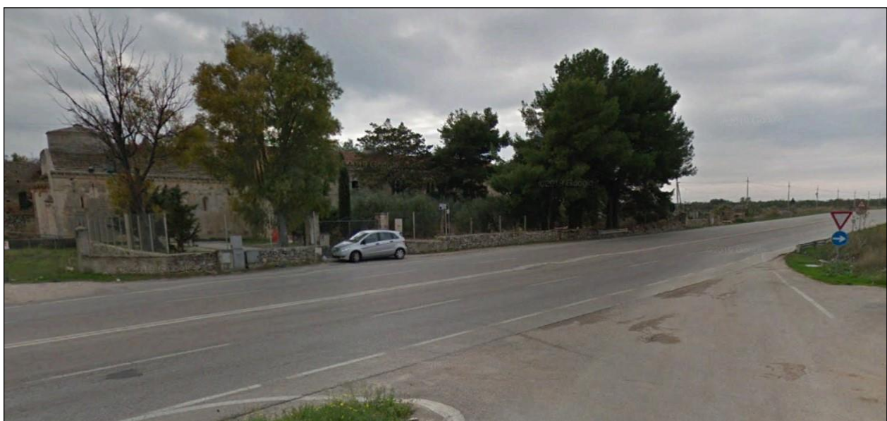
Figura 11 - Ante e post operam: ripresa fotografica dell'impianto dal punto PV5 di coordinate 567820.64 E; 4605387.39 N
