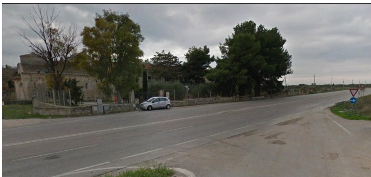
Figura 45 - Ante e post operam: ripresa fotografica dell'impianto dal punto PV5 di coordinate 567820.64 E; 4605387.39 N; l'impianto agrovoltaico risulta non visibile.
