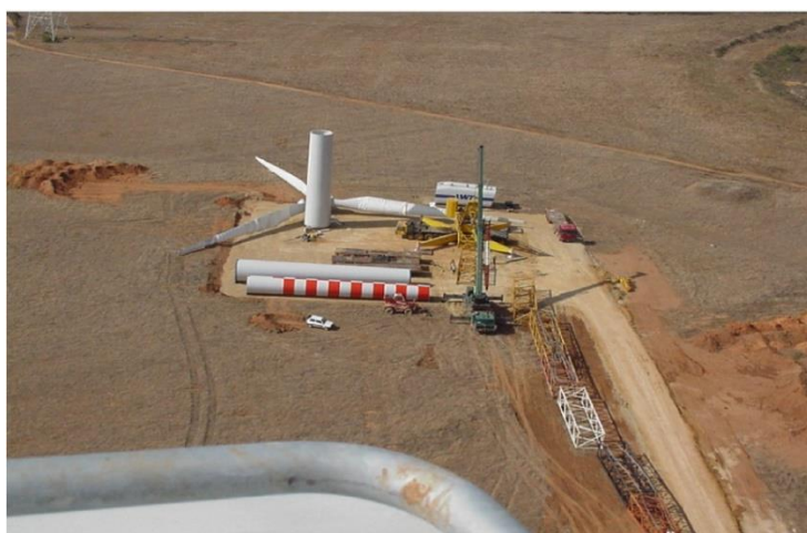
Figura 3 – Piazzola per il montaggio dell'aerogeneratore
