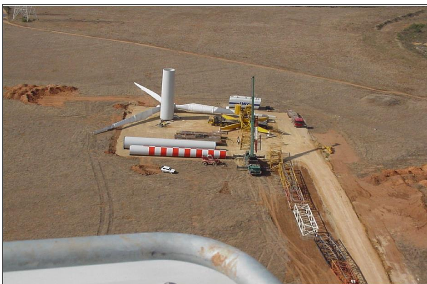
Foto 1. Piazzola per il montaggio dell'aerogeneratore
