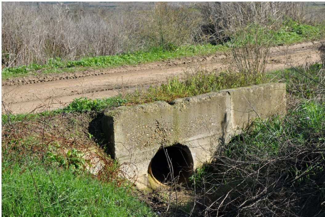
Attraversamento Rio Sassuni lato di valle
