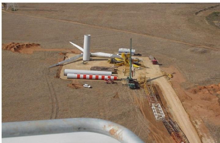
Figura 21 – Piazzola per il montaggio dell'aerogeneratore
