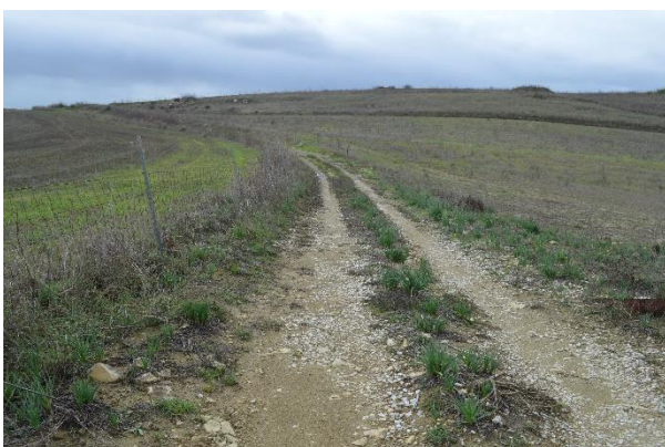
Figura 38 – Tratturo da adeguare
