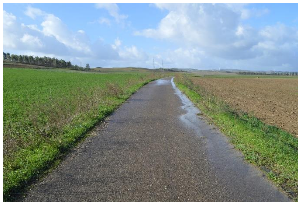
Figura 43 - Esempio di tratto asfaltato interessato dalla posa del cavidotto MT
