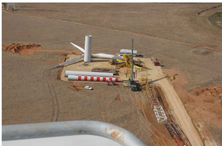
Figura 11 – Piazzola per il montaggio dell'aerogeneratore
