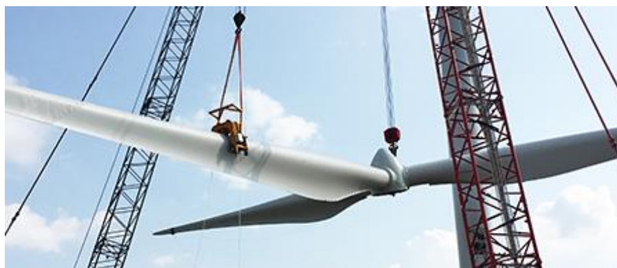
Figura 6-5 – sollevamento del rotore (Fonte: Elronic Wind solution)
