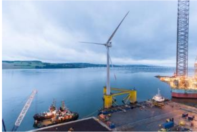
Figura 6-2 – Assemblaggio piattaforma galleggiante (Fonte kinkardine -Cobra)
