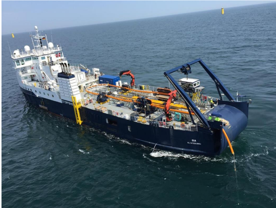
Figura 6-7 – Illustrazione dell'installazione del cavo (Fonte: Offshore Gode-wind)
