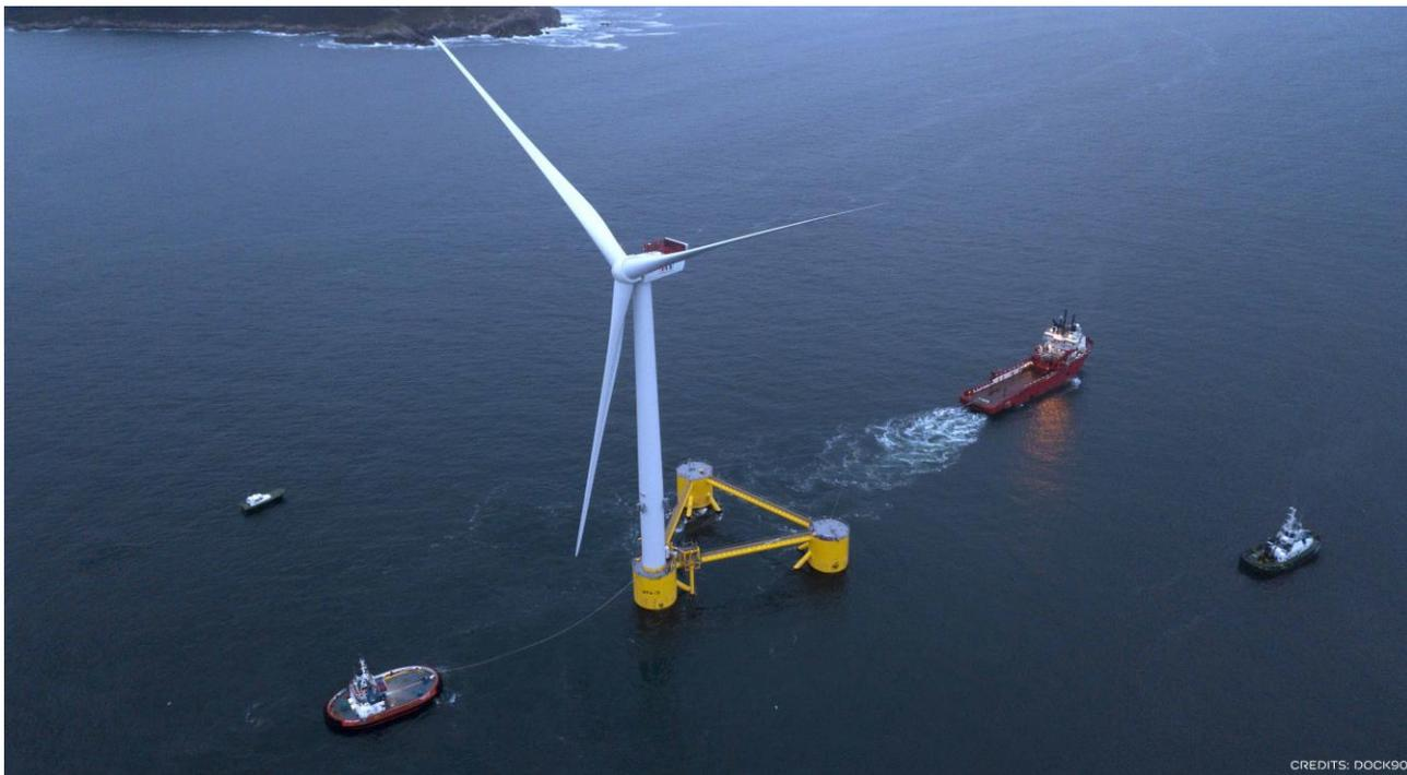
Figura 6-7 – Esempio dell'operazione di rimorchio (Fonte Windfloat Atlantic Project)
