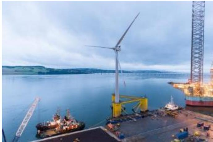
Figura 6-3 – Assemblaggio piattaforma galleggiante (Fonte kinkardine -Cobra)
