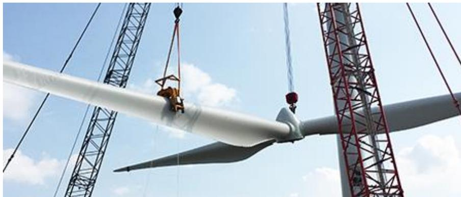
Figura 6-6 – sollevamento del rotore (Fonte: Elronic Wind solution)
