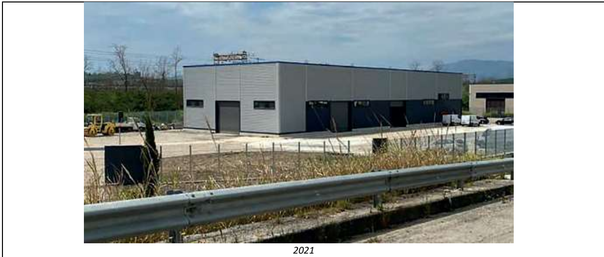
Figura 20 – Viste temporali dello Stabilimento ex Monosider presente nella zona di ricircolazione 1 della Figura 18
