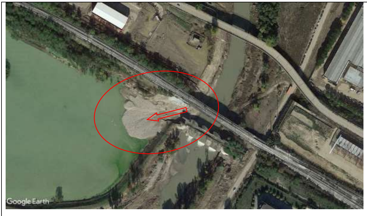
Figura 21 – Vista area vecchio attraversamento ferroviario con evidenze flusso evidenziate nella Figura 15 (novembre 2015 da GoogleEarth)
