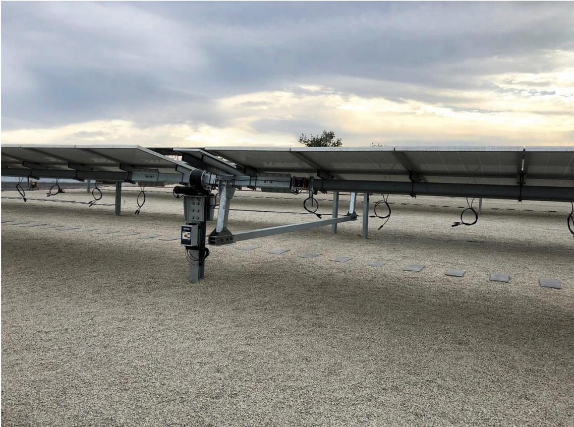
Axone è un motore tracker multi-fila con la capacità di spostare fino a 20 file e 62 moduli in totale sicurezza, riducendo l'uso di componenti elettronici, attuatori e motori di un fattore compreso tra 15 e 20 rispetto alla maggior parte degli inseguitori solari a fila singola soluzioni sul mercato. Ciò riduce i costi di manutenzione e l'indisponibilità dovuta a guasti.
